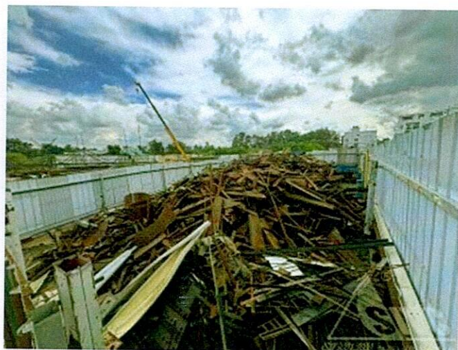
Hình 21: Hiện trạng vật tư thép tại khu vực 3
