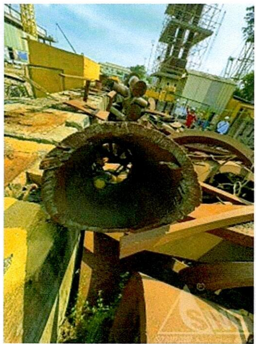
Hình 68: Hiện trạng vật tư thép tại khu vực 6
