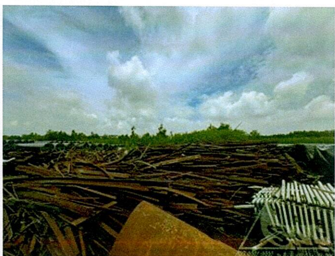
Hình 35: Hiện trạng vật tư thép tại khu vực 4
