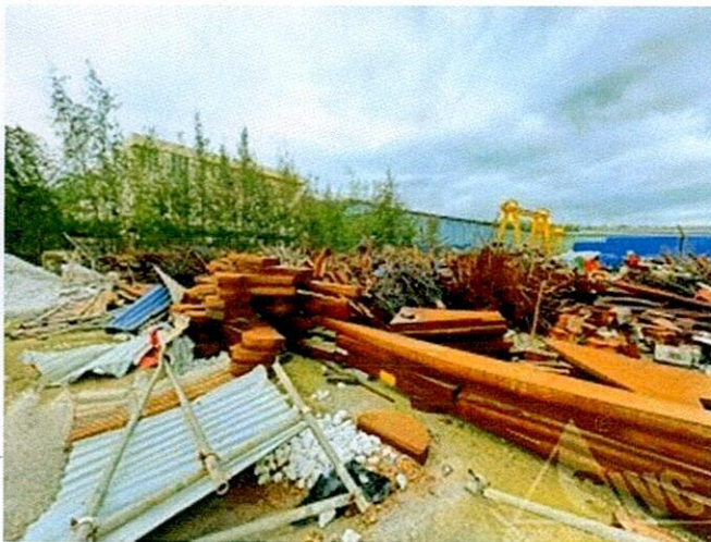
Hình 93: Hiện trạng vật tư thép tại khu vực 7
