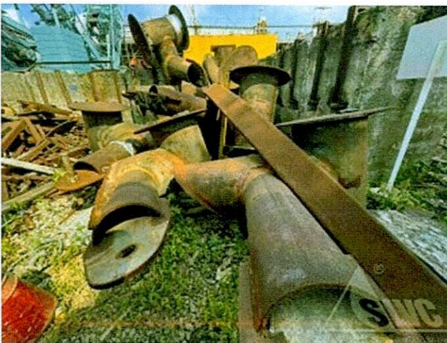
Hình 65: Hiện trạng vật tư thép tại khu vực 6
