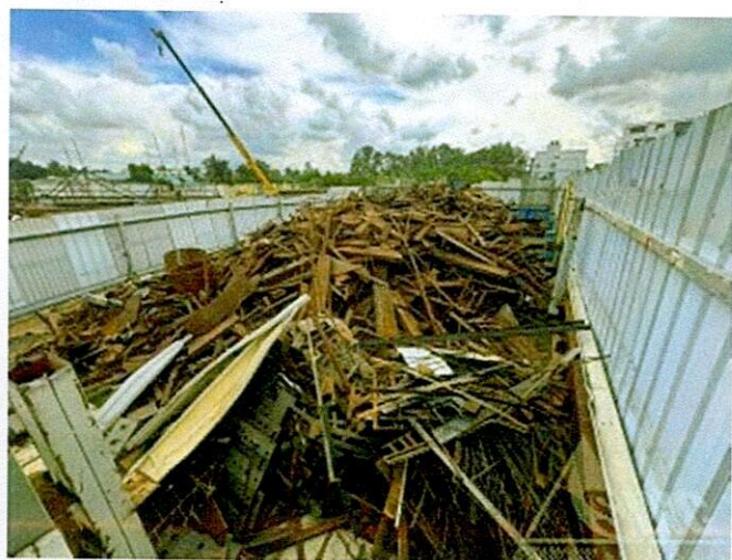
Hình 23: Hiện trạng vật tư thép tại khu vực 3
