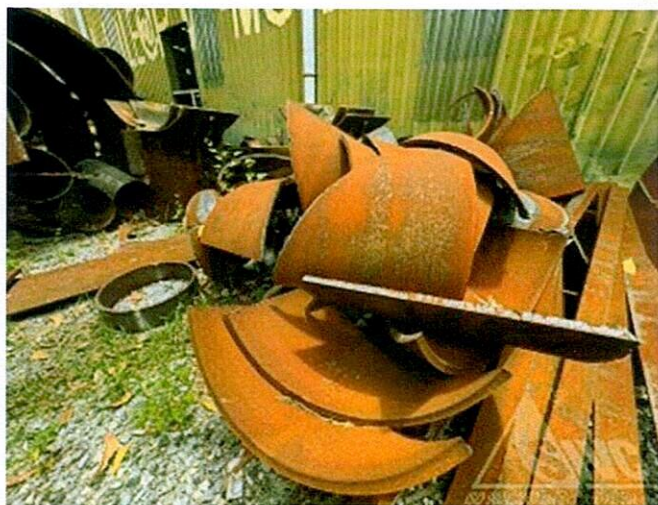
Hình 103: Hiện trạng vật tư thép tại khu vực 8
