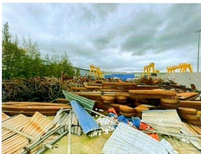
Hình 85: Hiện trạng vật tư thép tại khu vực 7
