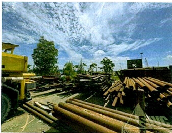
Hình 20: Hiện trạng vật tư thép tại khu vực 2
