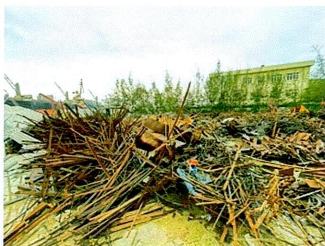
Hình 88: Hiện trạng vật tư thép tại khu vực 7
