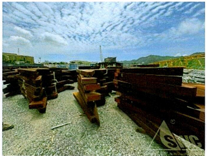
Hình 62: Hiện trạng vật tư thép tại khu vực 5
