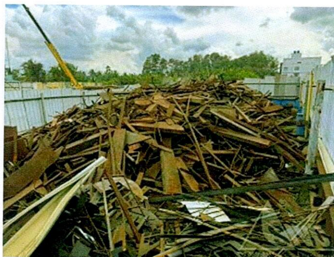
Hình 22: Hiện trạng vật tư thép tại khu vực 3
