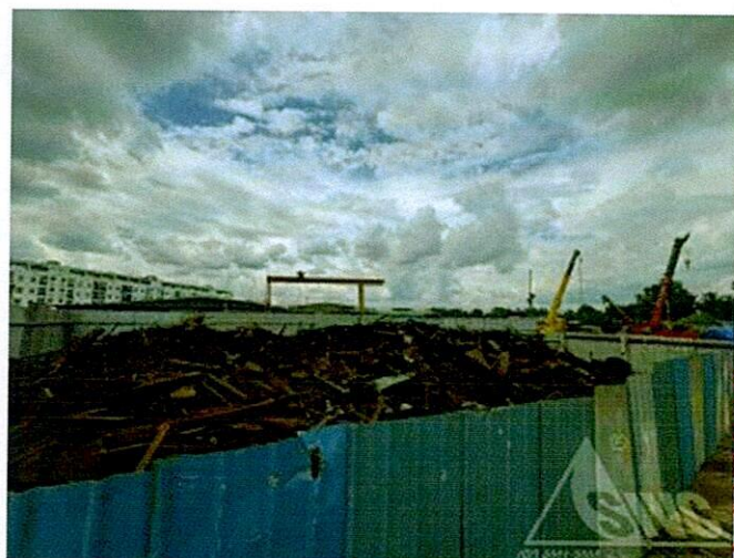
Hình 28: Hiện trạng vật tư thép tại khu vực 3
