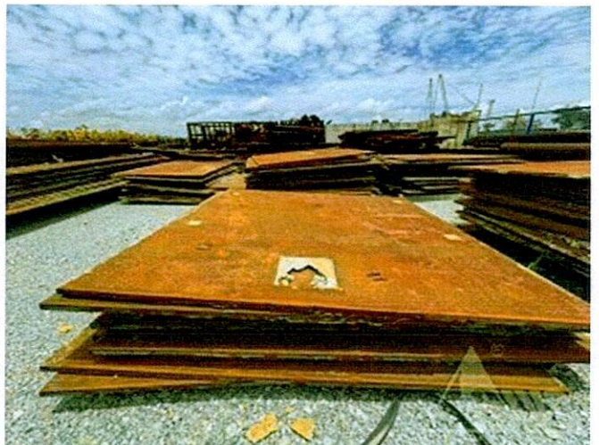
Hình 40: Hiện trạng vật tư thép tại khu vực 5
