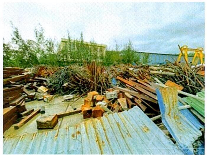
Hình 92: Hiện trạng vật tư thép tại khu vực 7
