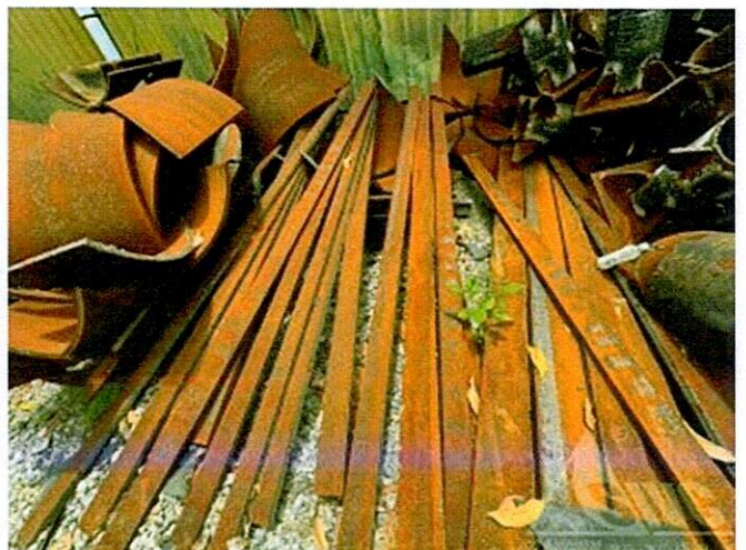
Hình 102: Hiện trạng vật tư thép tại khu vực 8
