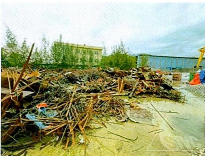
Hình 81: Hiện trạng vật tư thép tại khu vực 7
