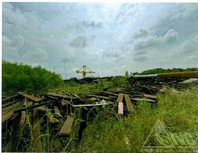
Hình 31: Hiện trạng vật tư thép tại khu vực 4
