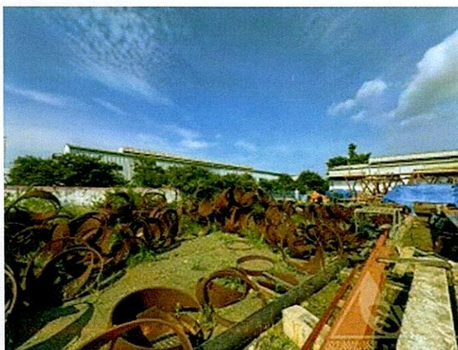
Hình 125: Hiện trạng vật tư thép tại khu vực 10
