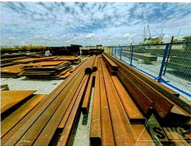
Hình 41: Hiện trạng vật tư thép tại khu vực 5
