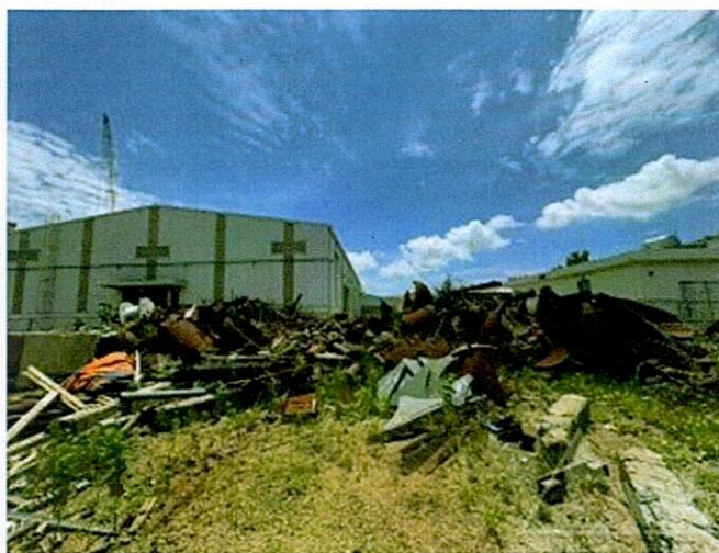
Hình 116: Hiện trạng vật tư thép tại khu vực 9
