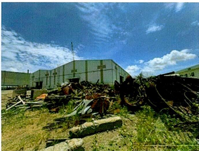
Hình 117: Hiện trạng vật tư thép tại khu vực 9
