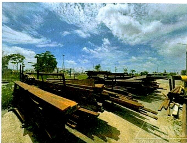
Hình 18: Hiện trạng vật tư thép tại khu vực 2
