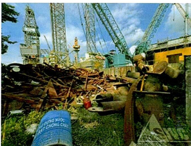
Hình 76: Hiện trạng vật tư thép tại khu vực 6
