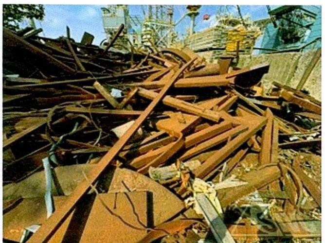
Hình 66: Hiện trạng vật tư thép tại khu vực 6
