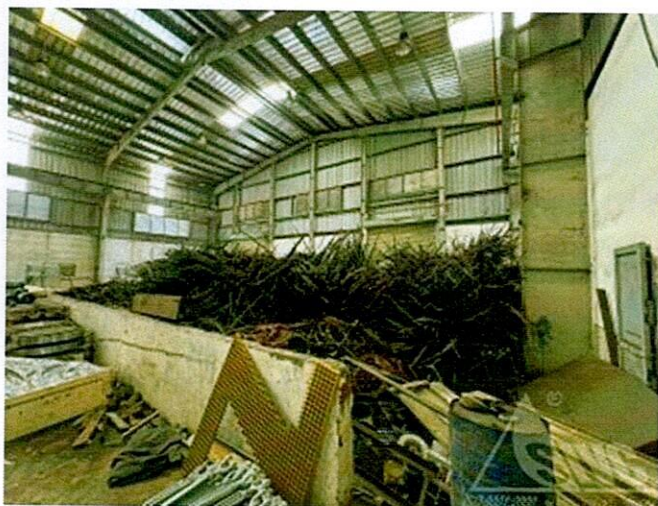
Hình 15: Hiện trạng vật tư thép tại khu vực 2
