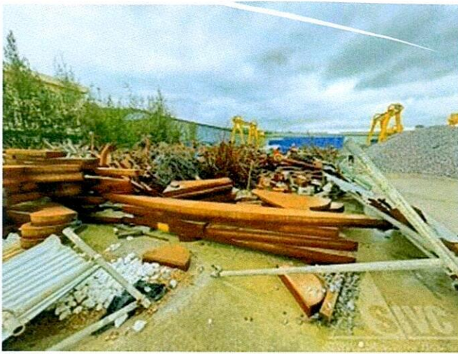
Hình 91: Hiện trạng vật tư thép tại khu vực 7
