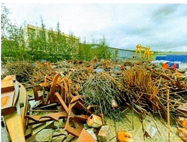
Hình 84: Hiện trạng vật tư thép tại khu vực 7
