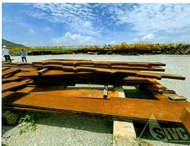
Hình 49: Hiện trạng vật tư thép tại khu vực 5
