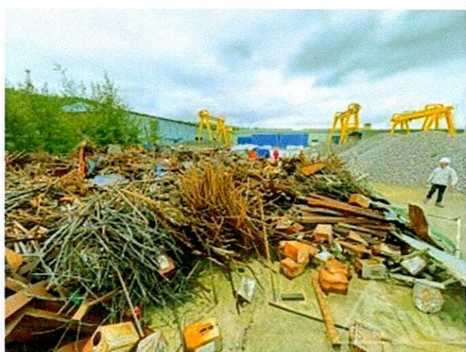
Hình 90: Hiện trạng vật tư thép tại khu vực 7
