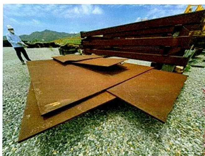
Hình 58: Hiện trạng vật tư thép tại khu vực 5
