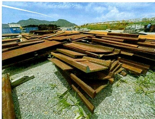
Hình 44: Hiện trạng vật tư thép tại khu vực 5
