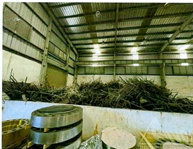
Hình 14: Hiện trạng vật tư thép tại khu vực 2
