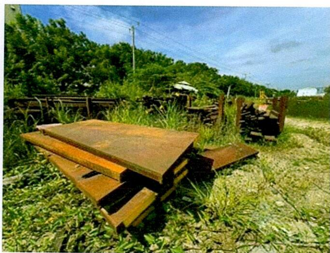
Hình 9: Hiện trạng vật tư thép tại khu vực 1
