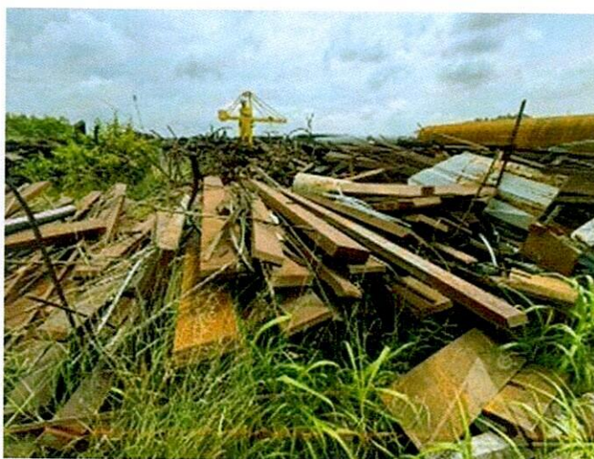
Hình 30: Hiện trạng vật tư thép tại khu vực 4
