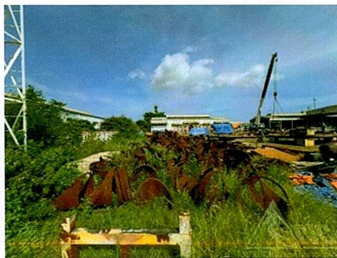
Hình 126: Hiện trạng vật tư thép tại khu vực 10
