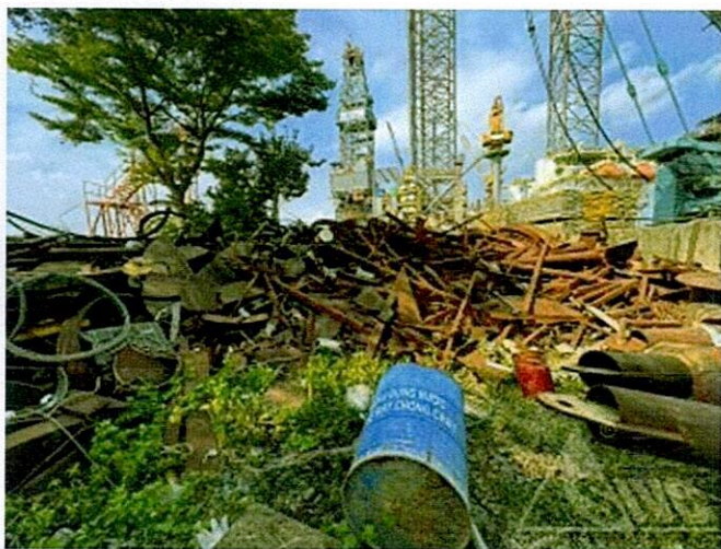
Hình 75: Hiện trạng vật tư thép tại khu vực 6
