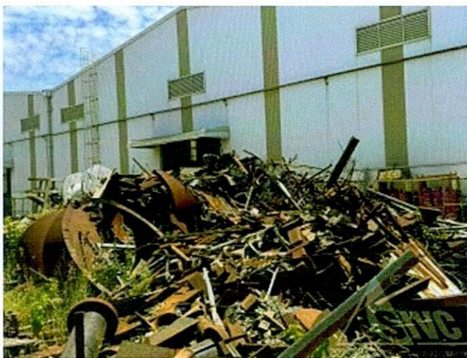
Hình 111: Hiện trạng vật tư thép tại khu vực 9
