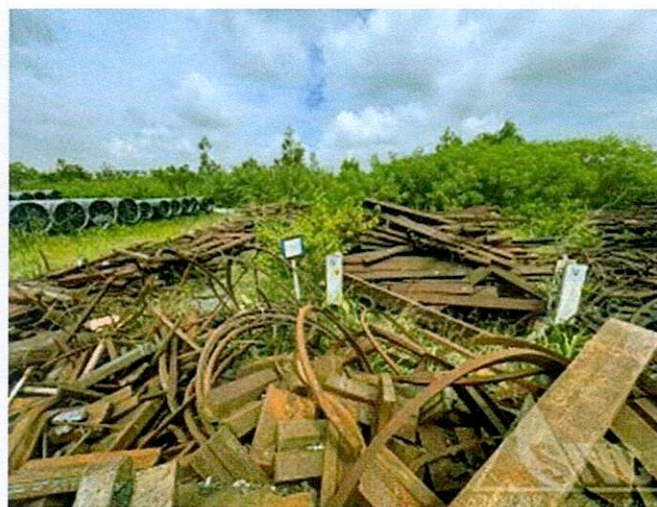
Hình 32: Hiện trạng vật tư thép tại khu vực 4
