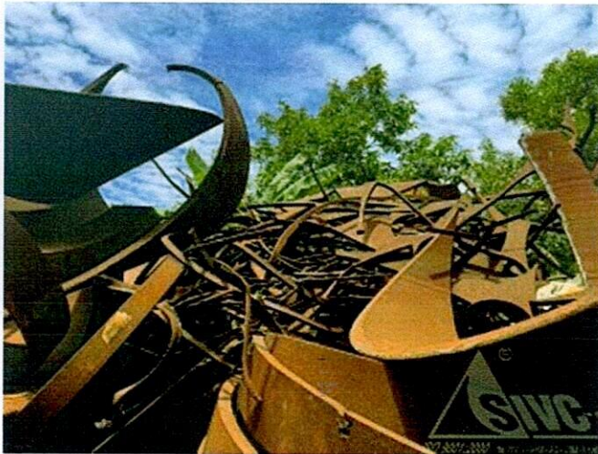
Hình 99: Hiện trạng vật tư thép tại khu vực 8
