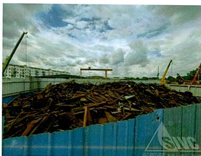
Hình 24: Hiện trạng vật tư thép tại khu vực 3
