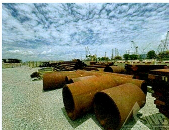
Hình 50: Hiện trạng vật tư thép tại khu vực 5
