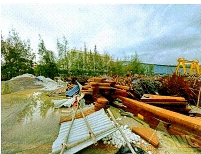
Hình 78: Hiện trạng vật tư thép tại khu vực 7
