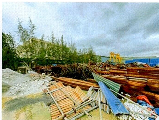
Hình 87: Hiện trạng vật tư thép tại khu vực 7
