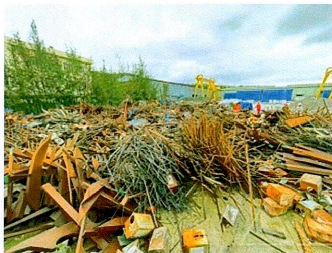
Hình 80: Hiện trạng vật tư thép tại khu vực 7
