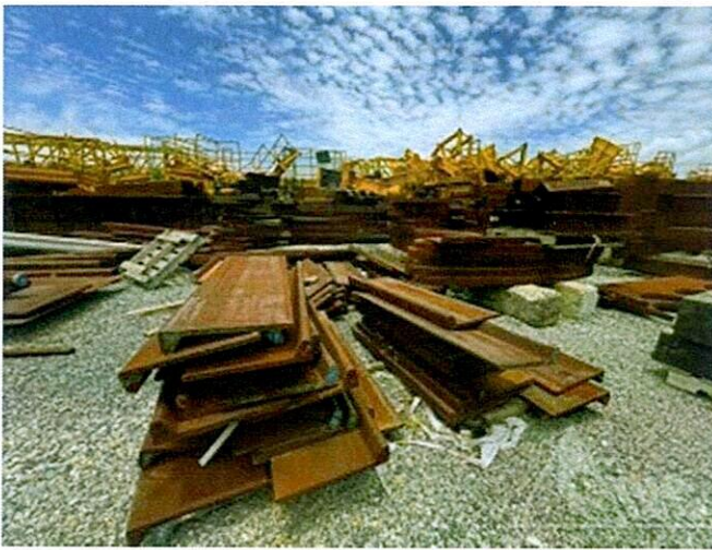
Hình 61: Hiện trạng vật tư thép tại khu vực 5
