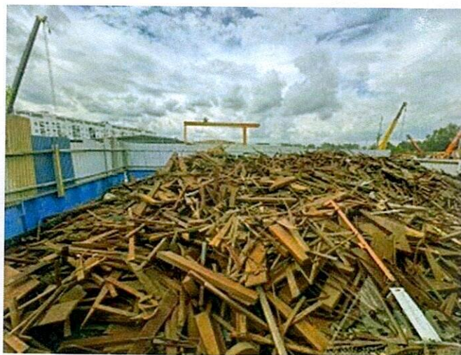
Hình 25: Hiện trạng vật tư thép tại khu vực 3
