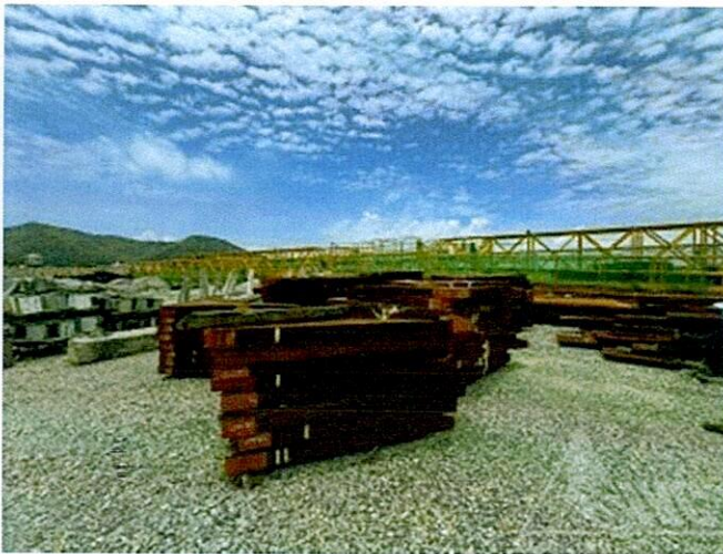
Hình 63: Hiện trạng vật tư thép tại khu vực 5
