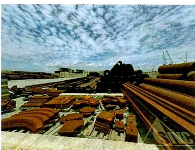
Hình 54: Hiện trạng vật tư thép tại khu vực 5
