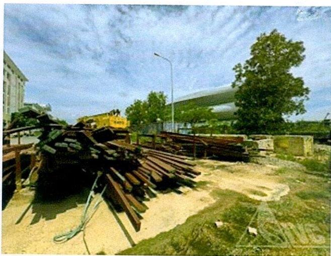
Hình 19: Hiện trạng vật tư thép tại khu vực 2
