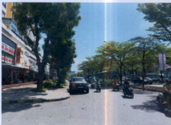
1 Hiện trạng đường trước chung cư
