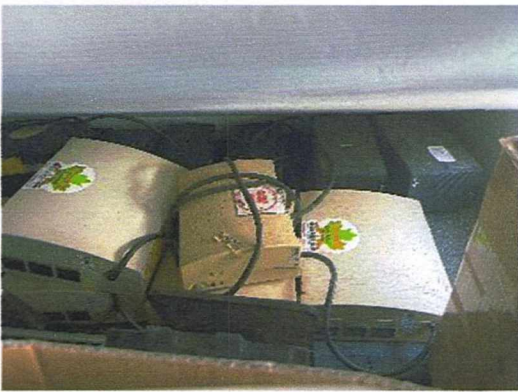
HIỆN TRẠNG UPS – LƯU ĐIỆN
