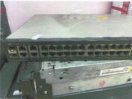
HIỆN TRẠNG SWITCH
