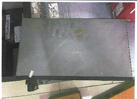
HIỆN TRẠNG SWITCH
