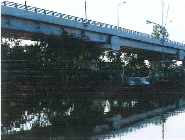
7. Đoạn đầu cầu Thái Bình
